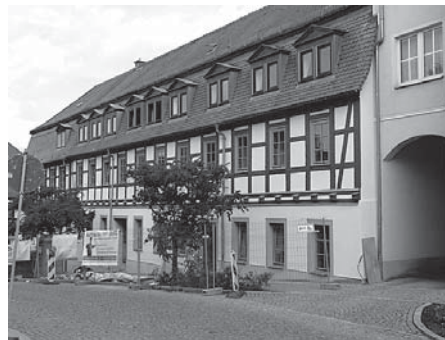
Während der Sanierung (Foto: Wohnungsverwaltung Schmölln GmbH)
